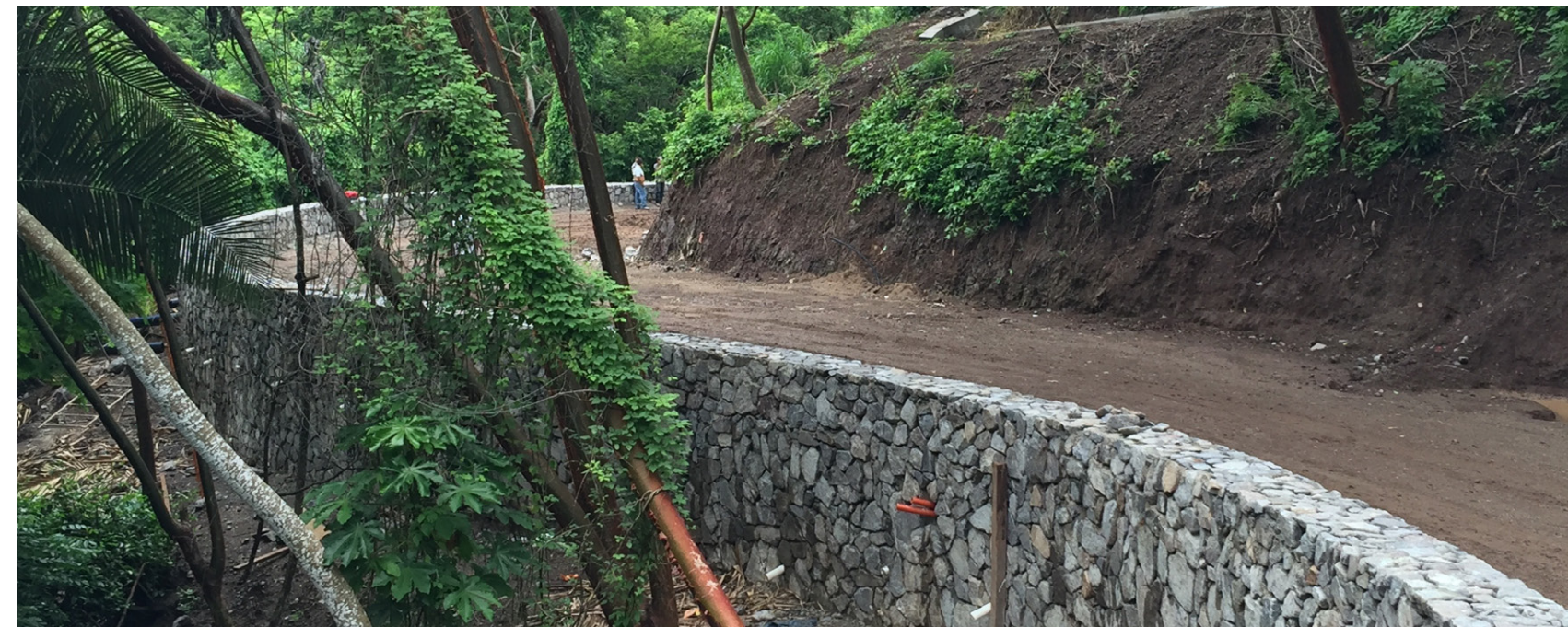
◆ LA MANDARINA 3 vialidades con muro de contención de piedra natural.
